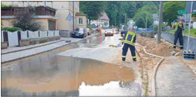
Aufräumarbeiten im Stt Krippen
