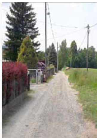
Bild: Stadtverwaltung - Ende Schanzenweg vor Baubeginn
