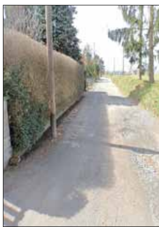
Bild: Stadtverwaltung - Anfang Schanzenweg vor Baubeginn
