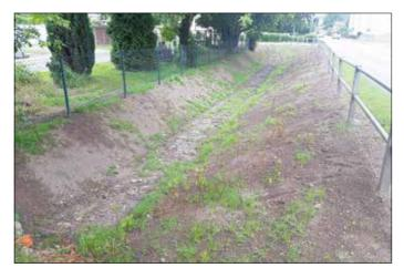
Die Sanierung des Flutgrabens an der B 172, Höhe Grundstück "Gas-Herrmann" konnte abgeschlossen werden. Die Ausführung erfolgte durch die Fa. Hartmannbau aus Rechenberg-Bienenmühle gemeinsam mit dem Bauhof der Stadt Bad Schandau. Der Graben dient als Hochwasserschutzanlage.
